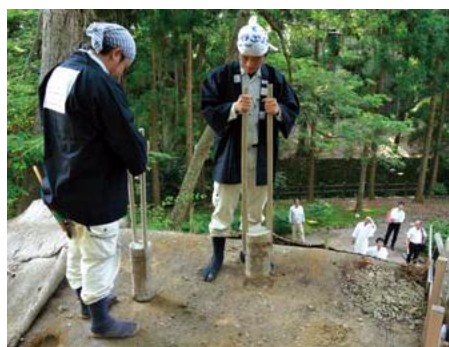
「版築工法」の作業
