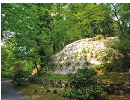
版築工法により復旧した御土居の法面（のりめん）
