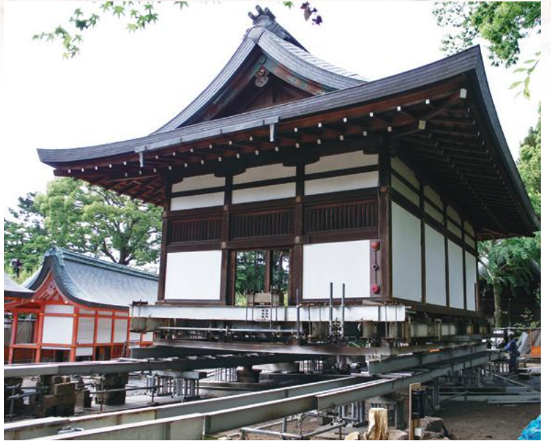
伝統の曳き家工法によって移築される紅梅殿
