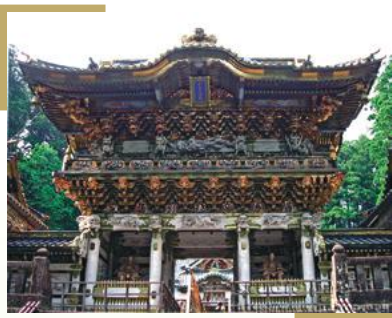
写真提供 日光東照宮 陽明門
