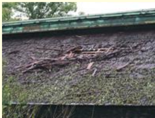
被害を受けた檜皮葺の御屋根
