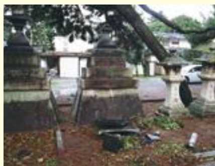
倒壊した石燈籠
