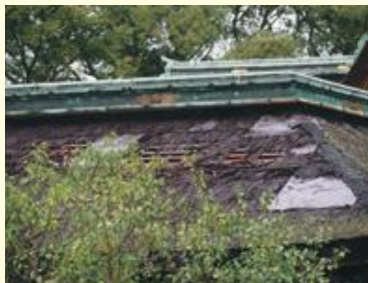
被害を受けた檜皮葺の御屋根
