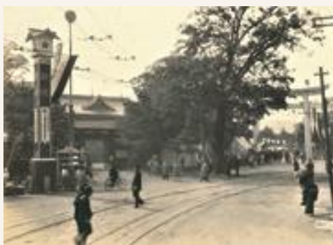
一ノ鳥居付近 写真左奥に武徳殿入口が映る（昭和三年）
