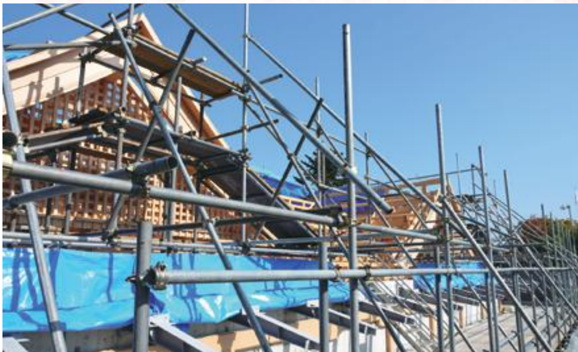
今秋竣工予定の仮称「北野文道会館」
