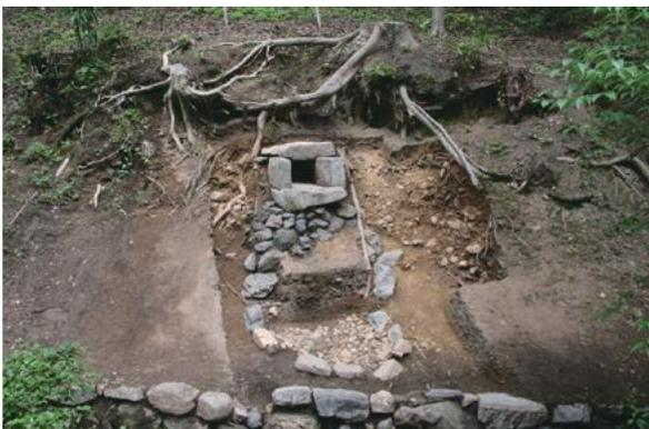
秀吉御土居石組暗渠 (悪水抜き 排水口)
